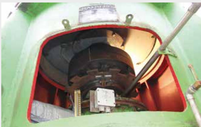
Anspruchsvolle Nachrüstung durch beengte Platzverhältnisse/ Demanding retrofit through confined spaces
