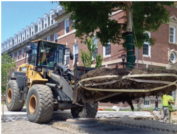
Dieser Baum am Williams College wurde unter Einsatz eines AirSpade wurzelnackt gemacht und als Teil eines neuen Innenhof-Bauprojekts umgepflanzt. (Foto freundlicherweise zur Verfügung gestellt von SSA.)
