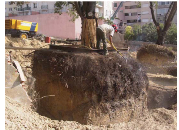
Das Freilegen der Wurzeln kann ein teilweises oder vollständiges Austauschen des Bodens ermöglichen, neue Erschließungsmaßnahmen erleichtern und eine lange Lebensdauer der Bäume fördern.
