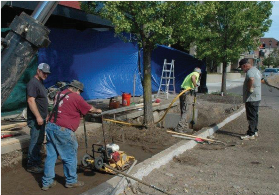
Installation eines neuen Pflastersystems für Ginkgo-Straßenbäume. Rechts im Foto hebt ein Baumpfleger stark verdichteten sandigen Lehm Boden aus, der 20 Jahre lang als Unterbau für das Ziegelpflaster gedient hatte. Links stellt der Bauunternehmer die Installation eines künstlichen, sandbasierten strukturellen Bodens fertig, auf dem das neue Pflaster angebracht werden soll.
