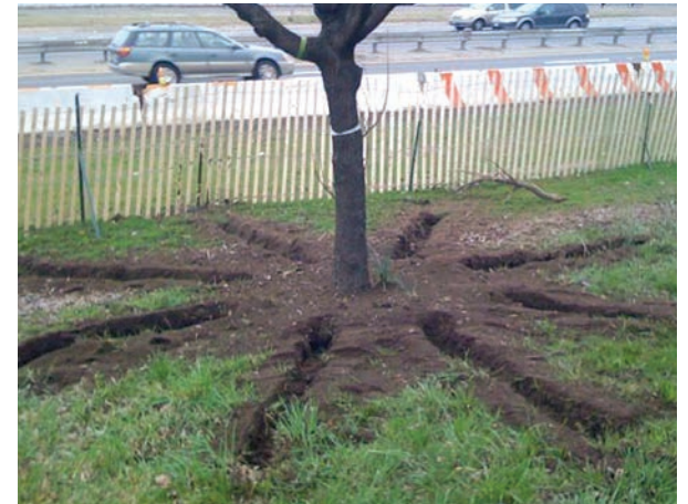
空気鋤で溝を掘った後、新しい土や改良材を加えた土で溝を埋めます。
