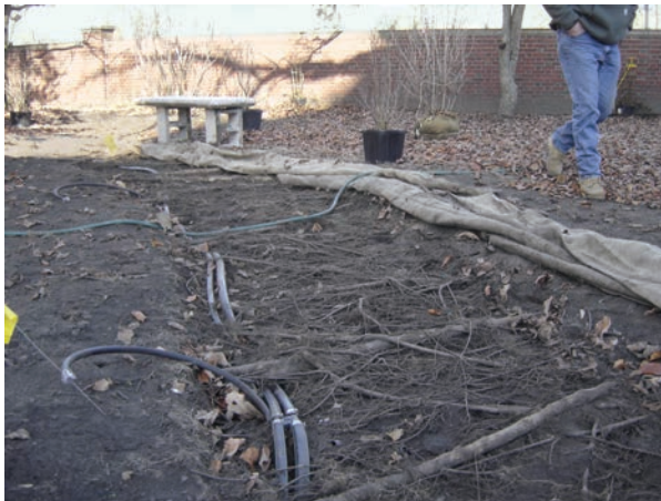
ラドクリフ研究所の新しい歩道の基盤はAirSpadeで掘りました。露出された根の間に灌水用の管を蛇行させて入れ、小石の根バリアと砕石舗装表層を施工する前に最低限の根の剪定を完了させました。（SSAが写真提供）
