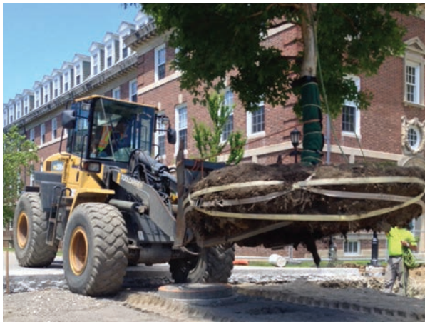
新校舎建築の際、ウィリアム大学にあるこの木の根はAirSpadeを使って掘り出され、移植されました。 (SSAが写真提供)
