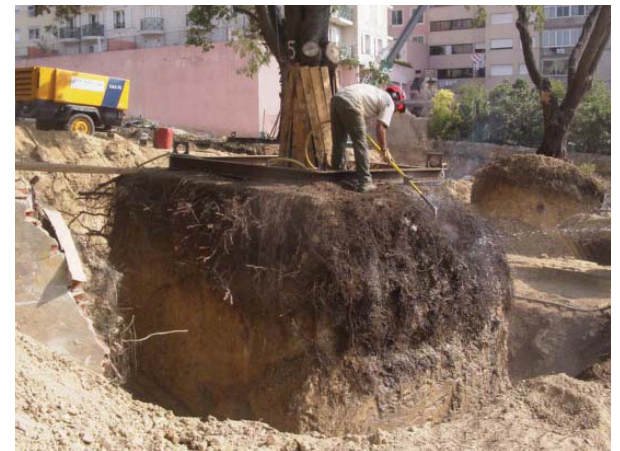
根の掘出し・露出作業により、部分的または完全な土壌の取替えが可能になり、新敷地の構築や樹木の延命につながります
