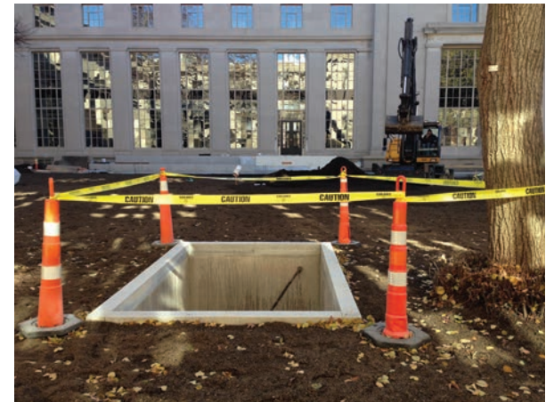
MITでこの地下室への通路を作るためには、入念な木の保護と熟練の高樹木専門職人によるAirSpadeを使った大規模な穴掘りと根の剪定を行うことが必要でした。（SSAが写真提供）
