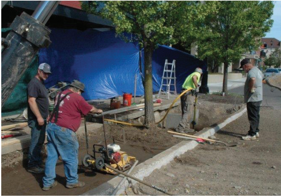
街路樹のイチョウの木の上に新規の舗装システムを敷く作業。この写真の右側では、20年以上レンガ舗装の下敷として非常に圧縮されたローム砂土壌を高樹木専門職人が掘り出しています。左側では土建業者が新舗装の重さに耐えることができる、砂をベースとした根系誘導耐圧土壌を挿入する最終作業をしています。
