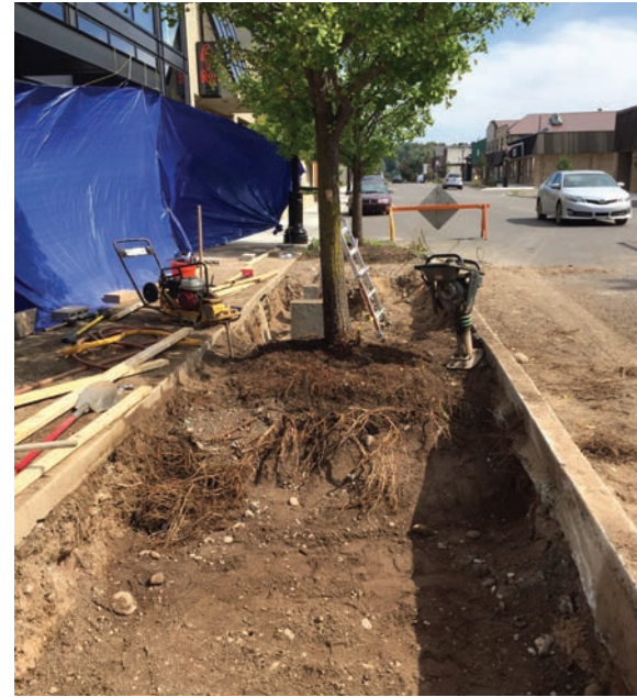
砂をベースとした根系誘導耐圧土壌を挿入する準備ができた、部分的に根が露出された街路樹のイチョウの木。 （写真提供はスティーブン スティムソン アソシエイツによる）。
