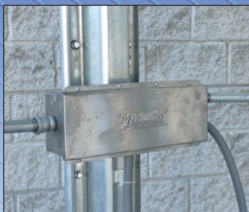
Caja suma inoxidable para conectar 4 hasta 16 celdas
