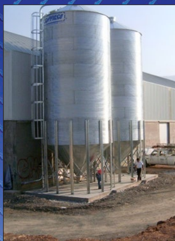
Silo con columnas de apoyo
