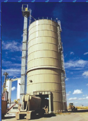
Silo de faldón con paso de vehículos
