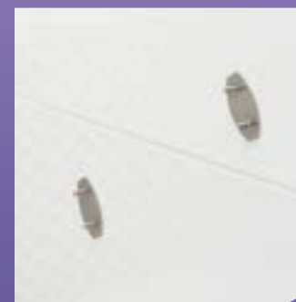
lijmbevestiging met RVS muurplaatjes
