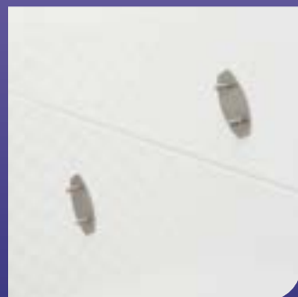
lijmbevestiging met RVS muurplaatjes
