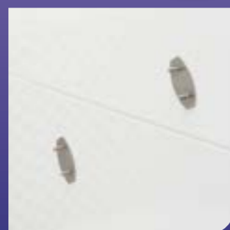
lijmbevestiging met RVS muurplaatjes
