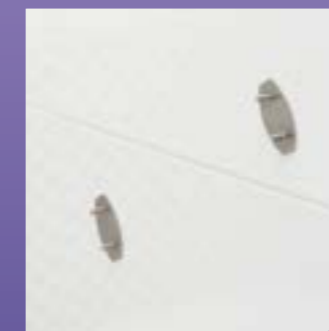
lijmbevestiging met RVS muurplaatjes
