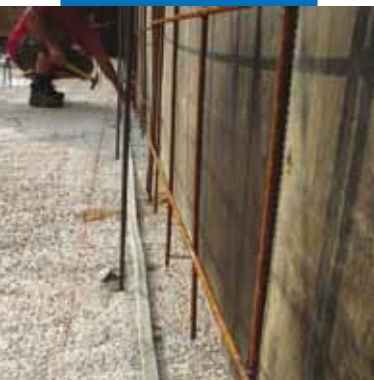
Aplicação do Idrostop B25
