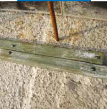
Sobreposição das extremidades do Idrostop B25
