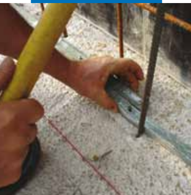
Sobreposição das extremidades do Idrostop B25
