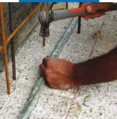
Fixação do Idrostop B25 na junta de betonagem
