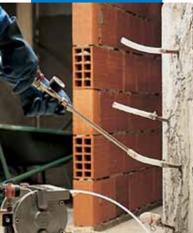
Injeção de Epojet no pilar fissurado
