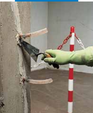
Fixação dos injetores com Adesilex PG1
