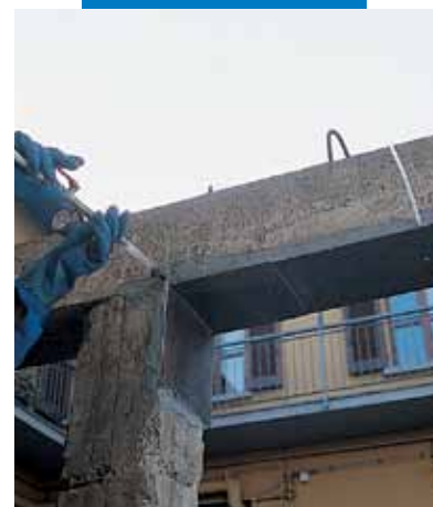
Placagem de travessas mediante injeção de Epojet
