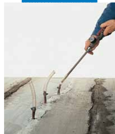
Reparação de estrutura horizontal mediante injeção de Epojet
