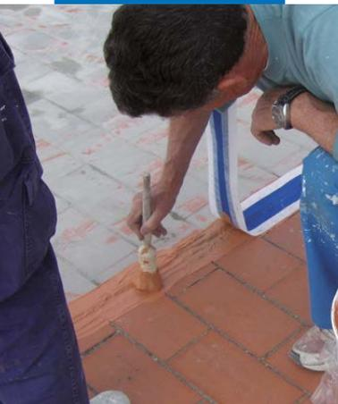
Impermeabilização de uma junta de fracionamento com Mapeband fixado com Aquaflex Roof
