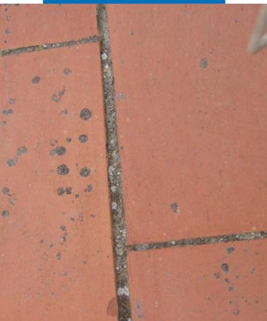
Pavimento existente em tijoleira que necessita de preparação antes do assentamento de Aquaflex Roof
