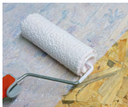
Aplicação do primário. Escolha o primário adequado ao suporte. Aplicar sobre toda a superfície e deixar secar.
