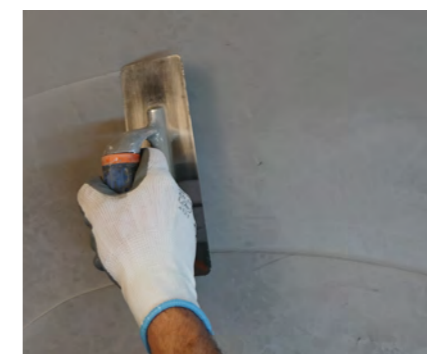
Aplicação da 2ª camada dando o efeito de espatulado para obter o acabamento final desejado.
