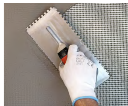
Aplicação da rede fibra de vidro.
