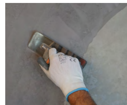
Aplicação da 1ª camada de Tubetão Microcimento FT.
