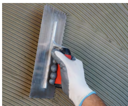
Aplicação da 1ª camada de Tubetão Microcimento G para regularização do suporte.
