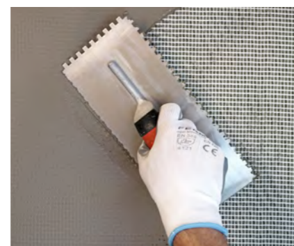
Aplicação da rede fibra de vidro.
