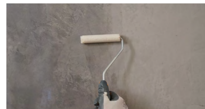
Aplicação do primário Topeca Micro Sealer e posterior aplicação do verniz Topeca Micro Varnish PU.
