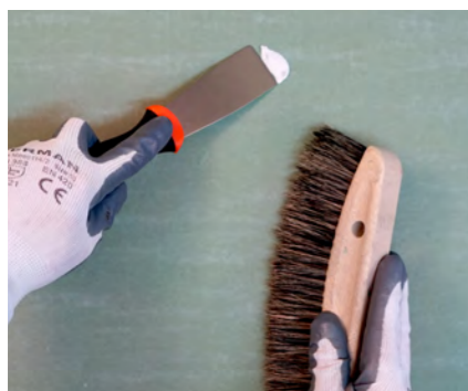
Limpeza da superfície.
