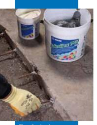
Fixação dos ferros para a ancoragem com Adesilex PG1
