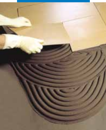
Assentamento de grés porcelânico sobre betonilha impermeabilizada com Mapelastic
