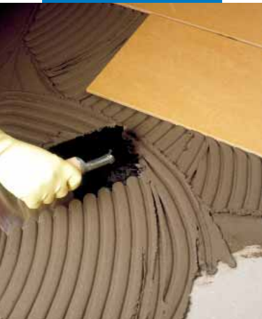
Aplicação de Elastorapid com espátula dentada sobre betonilha cimentícia
