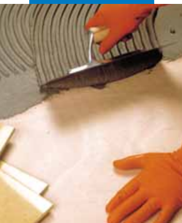
Assentamento de grés porcelânico com Elastorapid sobre suporte em contraplacado marítimo
