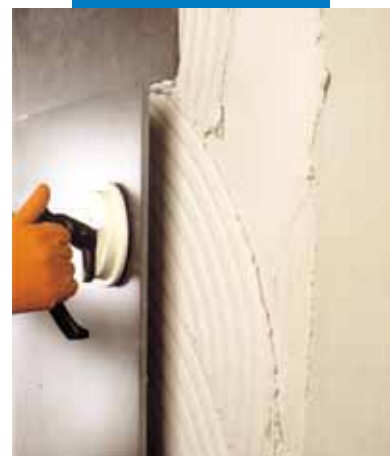
Assentamento de grés porcelânico de grande formato com Elastorapid sobre betão em fachada
