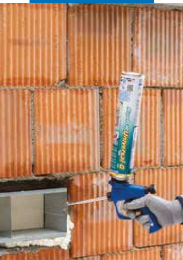
Enchimento de canais de ventilação
