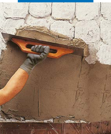
Regularização à talocha
