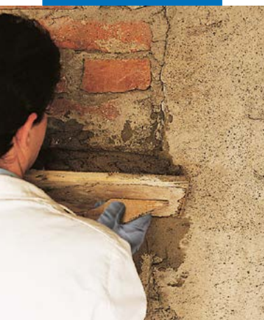
Restauração de alvenaria antiga
