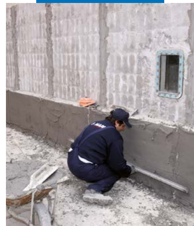
Regularização do reboco com régua
