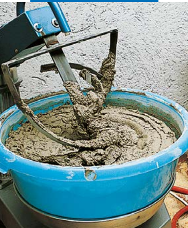
Mistura com mini-betoneira
