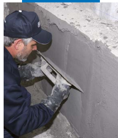
Aplicação de Nivoplan à talocha
