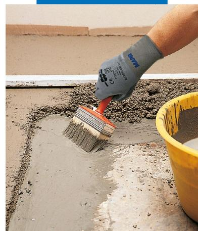
Colocação de aguadas de ancoragem para betonilhas Mapecem aderentes
