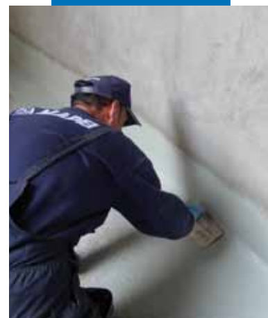
Mapelastic Foundation aplicado à espátula numa intervenção de impermeabilização em pressão negativa
