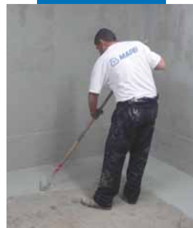
Mapelastic Foundation aplicado a rolo numa intervenção de impermeabilização em pressão negativa
