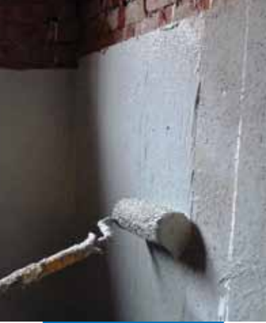
Aplicação de Mapelastíc Foundation a rolo sobre suporte precedentemente regularizado com Planitop HDM Maxi
