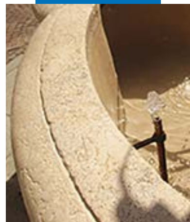
Impermeabilização da bacia de uma fonte de pedra
