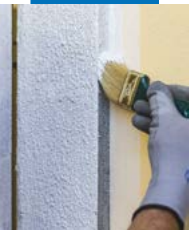
Proteção de uma caixilharia com Mape-Antique Ecolastic
