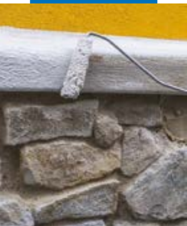
Impermeabilização da frente de um muro com Mape-Antique Ecolastic
