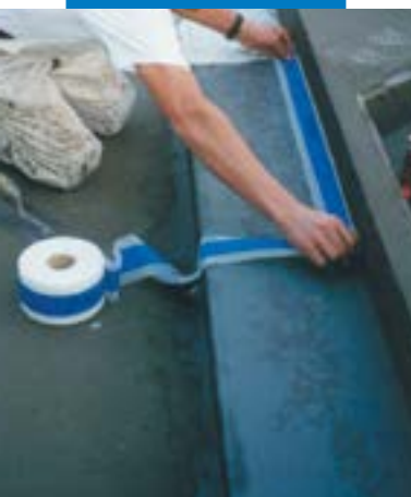
Exemplo de impermeabilização de Mapeband num ângulo entre o fundo e parte de um tanque
