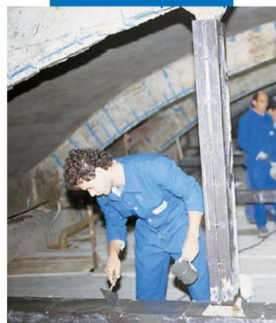
Vazamento de Mapegrout Colabile em cofragem metálica
