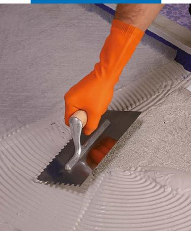
Aplicação da primeira camada de Monolastic armado com Mapetex Sel sobre a nova betonilha
