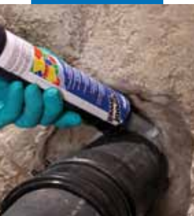
Aplicação de Mapeproof Swell à volta do tubo
