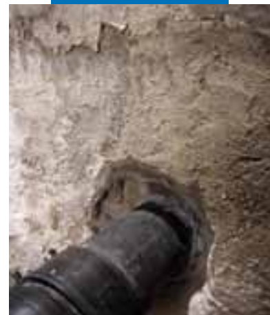
Mapeproof Swell aplicado
