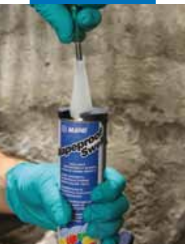
Perfuração da membrana de proteção de Mapeproof Swell
