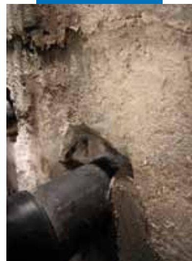
Confinamento de Mapeproof Swell com Mapegrout T40
