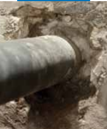
Demolição da estrutura à volta do tubo
