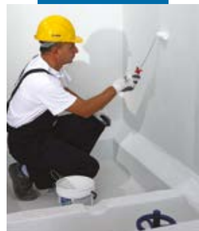
Aplicação a rolo de Mapecoat DW 25
