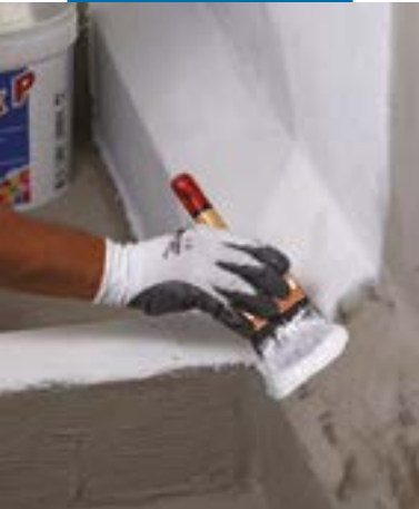
Aplicação a pincel de Triblock P sobre suporte húmido
