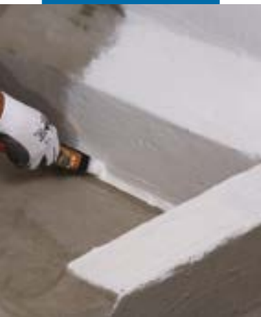
Aplicação de Triblock P na ligação entre o pavimento e a parede
