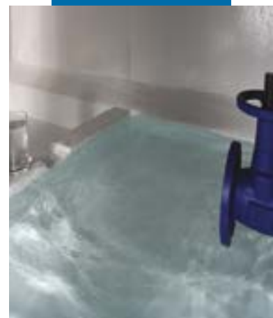
Enchimento do tanque após o endurecimento completo de Mapecoat DW 25
