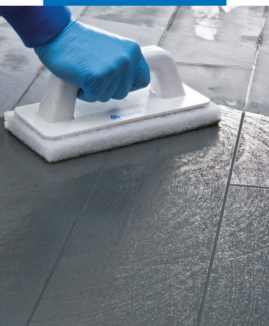
Limpeza das juntas com Scotch-Brite® (com produto parcialmente endurecido)
