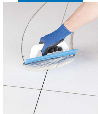
Aplicação de Ultracolor Plus em pavimento com espátula de borcha sobre ladrilhos em grés porcelânico
