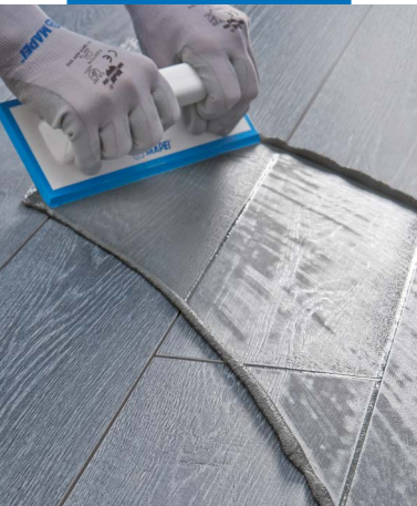
Aplicação de Ultracolor Plus em pavimento com espátula de borracha sobre ladrilhos em grés porcelânico efeito madeira
