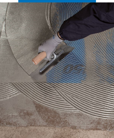
Inserção de Mapenet 150 na primeira demão de Mapelastic Turbo fresco
