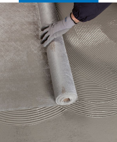
Inserção de Mapetex Sel na primeira demão de Mapelastic Turbo fresco
