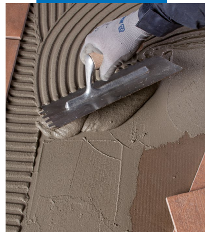
Assentamento de ladrilhos com Elastorapid
