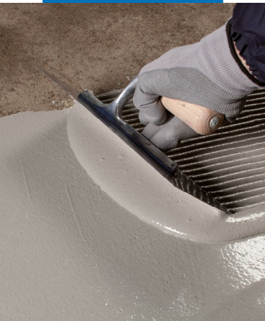
Aplicação da primeira demão do Mapelastic Turbo
