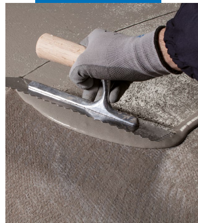
Segunda demão de Mapelastíc Turbo sobre a primeira armada com Mapetex Sel
