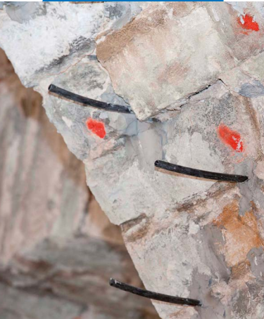
Detalhe da fixação dos tubos de injeção
