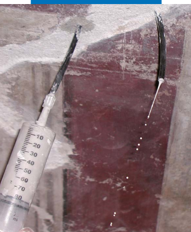
Injeção de Mape-Antique F21 na presença de frescos
