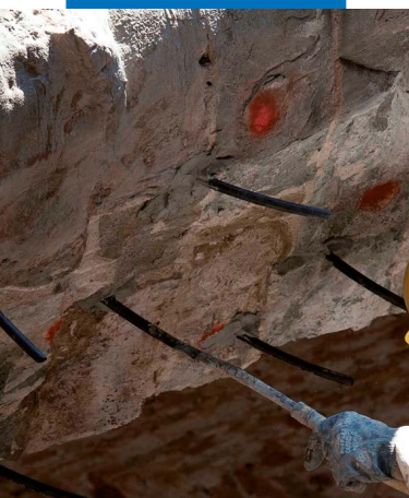
Injeção de Mape-Antique F21 numa alvenaria em pedra
