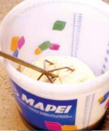
Mistura de Mapeset com o agitador mecânico
