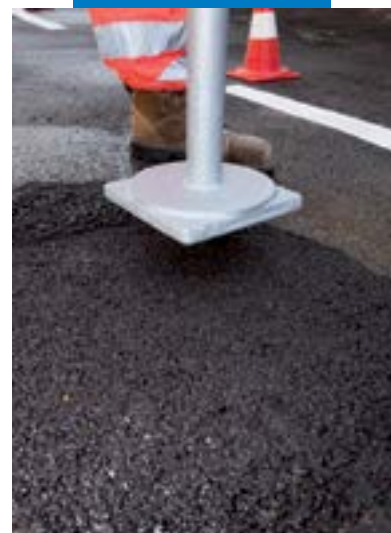
Compactação manual de Mape-Asphalt Repair 0/8
