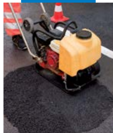
Compactação mecânica de Mape-Asphalt Repair 0/8
