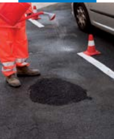
Molhagem da superfície de Mape-Asphalt Repair 0/8
