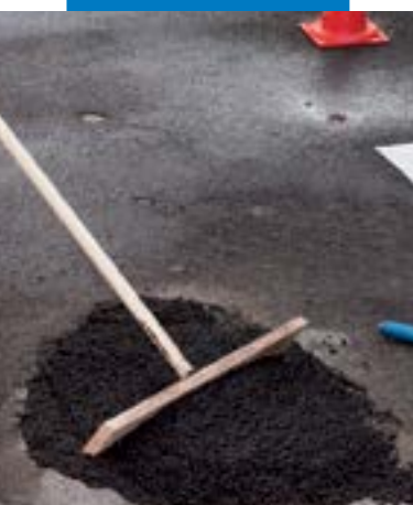
Aplicação de Mape-Asphalt Repair 0/8
