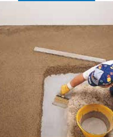
Aplicação da aguada de ancoragem para betonilhas aderentes em Topcem
