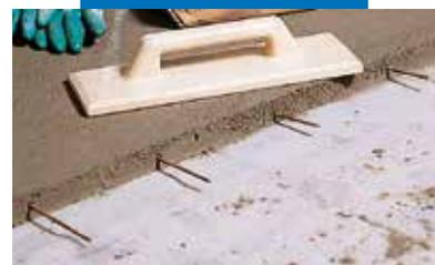
Particularidade da betonilha em Topcem com ferros de juntas de betonagem
