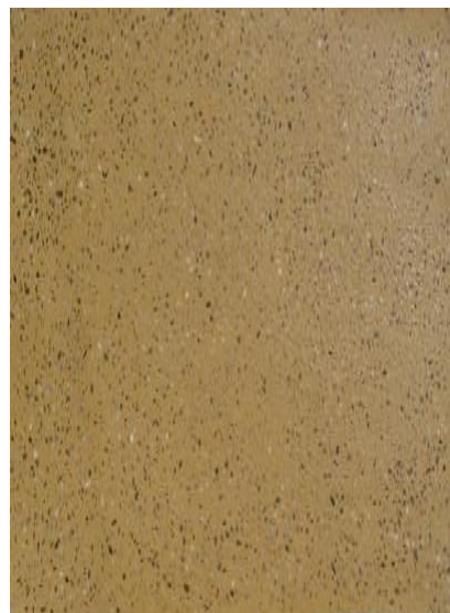
5. Após cura completa, aplicação do protetor de superfícies B-REPARA PROTEÇÃO AD 40 .
