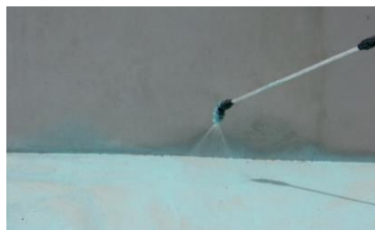
2. Pulverização do SCALA AD 32 nas superfícies frescas do pavimento;
