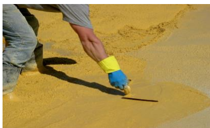
1. Talochamento das superfícies frescas do betão de pavimento;
