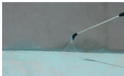
2. Pulverização do SCALA AD 31 nas superfícies frescas do pavimento;
