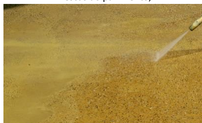
4. Remoção com jato de água da camada superficial, expondo o agregado;
