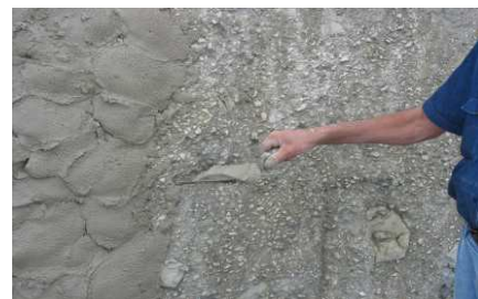
Aplicação manual do B-REPARA FACE R2
