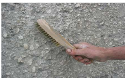
Remoção das matérias desagregadas
