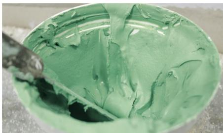
1. Introduzir progressivamente um saco de 5kg de pó em cerca de 2,5 L de água limpa (ou saco de 15kg para 7,5 L de água), e deixar repousar entre 2 a 3 min. Misturar mecanicamente com misturador a baixa velocidade (500 rpm) por forma a obter uma pasta homogénea e com consistência plástica.
