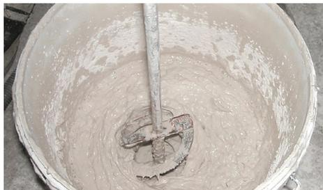
1. Introduzir progressivamente um saco de 15 kg ou de 5 kg de pó em cerca de 7 L e 2,5 L de água limpa, respetivamente, e deixar repousar entre 2 a 3 min. Misturar mecanicamente com misturador a baixa velocidade (500 rpm) por forma a obter uma pasta homogénea e com consistência plástica.
