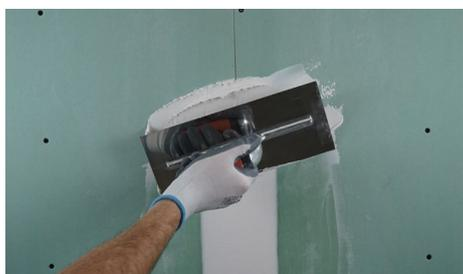
3. Recobrir a banda com uma nova camada de Tuforte juntas e deixar endurecer (nível de acabamento Q1).
