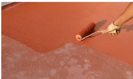
**Notas:** Quando necessário (ex.: suportes fissurados) aplicar rede fibra de vidro **Topeca Net**. A rede deve ser estendida sobre a segunda camada de Topelastic Acrylic, ainda fresca, e selada com a terceira camada.
