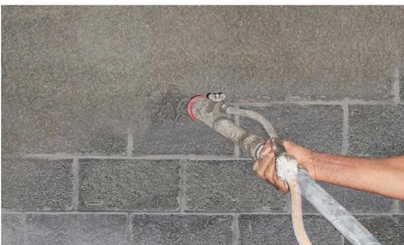
1. A mistura do Rebetop RPT h com água limpa deve ser efetuada em equipamento de projeção. Regular o caudal de água de forma a obter uma argamassa com consistência plástica.
