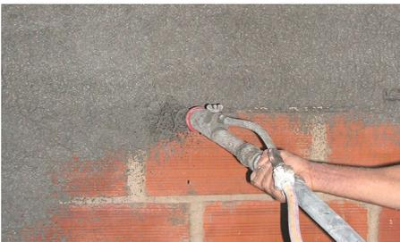
**1.** A mistura do Rebetop Plus+ Multi com água limpa deve ser efetuada em equipamento de projeção. Regular o caudal de água de forma a obter uma argamassa com consistência plástica.
