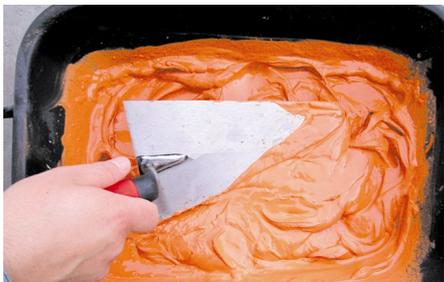
1. Misturar manualmente ou mecanicamente Juntaemcor com cerca de 1L de água por 3 kg de Juntaemcor (como dado orientativo para uma junta com cerca 4mm), até obter uma pasta homogénea e sem grumos.
