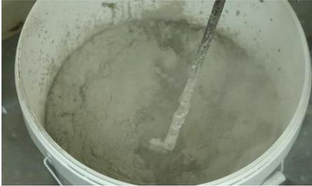
1. Autonivelante Nível X deve ser amassado com água limpa, em quantidade de acordo com a espessura a aplicar.
