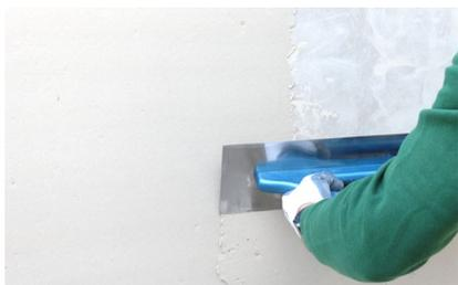
2. Espalhar o Tuforte Kaltech Liso com talocha metálica ou espátula, em camadas finas sucessivas, até perfazer uma espessura de 2 a 4 mm. Alisar a superfície.
