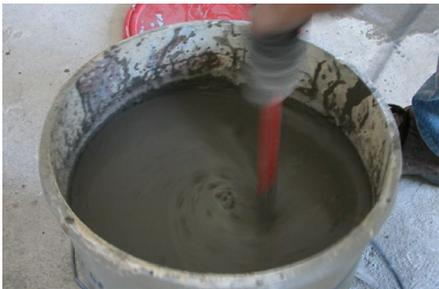
1. Misturar mecanicamente um saco de 25 kg de Topliga Wet com 12,5 L de água limpa, até obter uma argamassa de consistência plástica.
