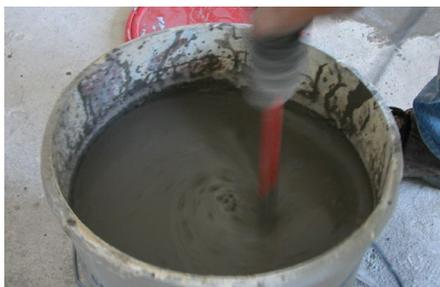
1. Misturar mecanicamente o Topliga Dry com a quantidade de água limpa abaixo tabelada, de acordo o método de aplicação previsto, até obter uma pasta de consistência plástica.
