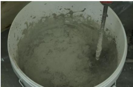
1. Misturar o Topliga mecanicamente com 3,5 kg de água até obter um argamassa de consistência plástica.
