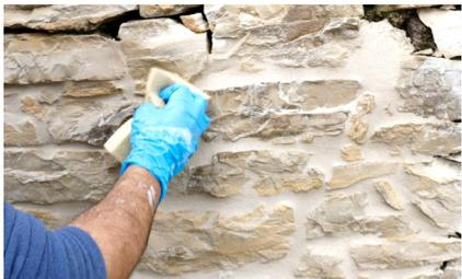
**1.** A aplicação do Topeca Kaltech Joint pode ser efetuada de acordo com processo manual ou por projeção mecânica (preferencial).
