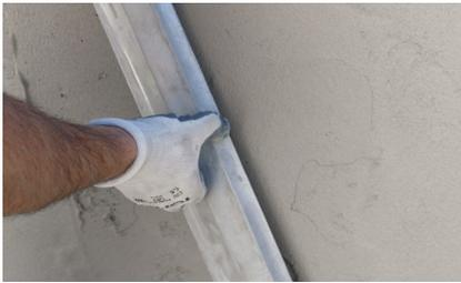
4. Proceder ao acabamento desejado após endurecimento do reboco. Aferir o momento correto através da realização do **Teste de Pressão\***.
