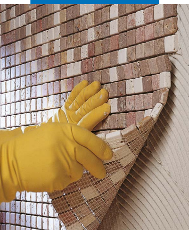
Assentamento de pastilha de mármore 2x2 em parede
