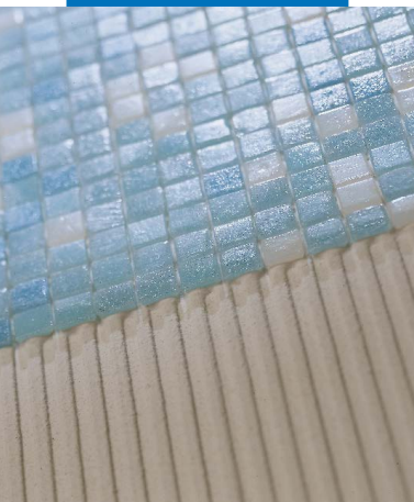
Assentamento de pastilha de vidro 1x1 em parede
