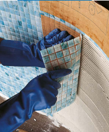
Assentamento de pastilha de vidro 2x2 em piscina com Adesilex P10 mais Isolastic diluído 1 : 1 com água
