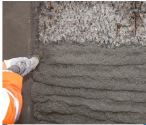
Aplicação por projeção de Mapegrout 430 Zero
