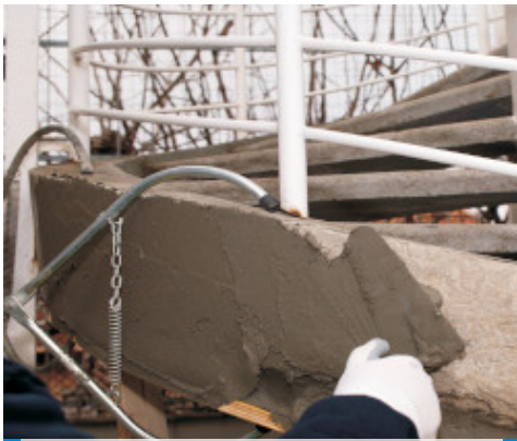
Aplicação à mão de Mapegrout 430 Zero
