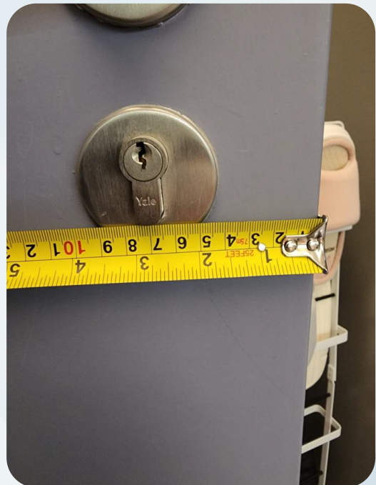
現有門鎖 Existing door Lock
