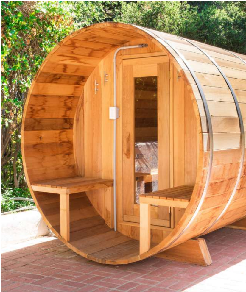
Weatherproof Conduit & Light Switch
