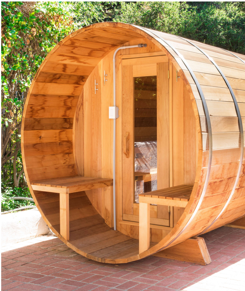
Weatherproof Conduit & Light Switch
